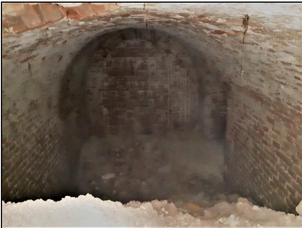
Kellereinbruch; vor dem Haus Bründlgasse 18; Nov. 2020; Handelt es sich bei dem geöffneten Keller um den oft genannten „Keller bei den Hofstadln“? Gibt es vielleicht sogar noch ein Foto, auf dem an dieser Stelle oder in der Nähe davon ein Keller-Vorhaus sichtbar ist???
